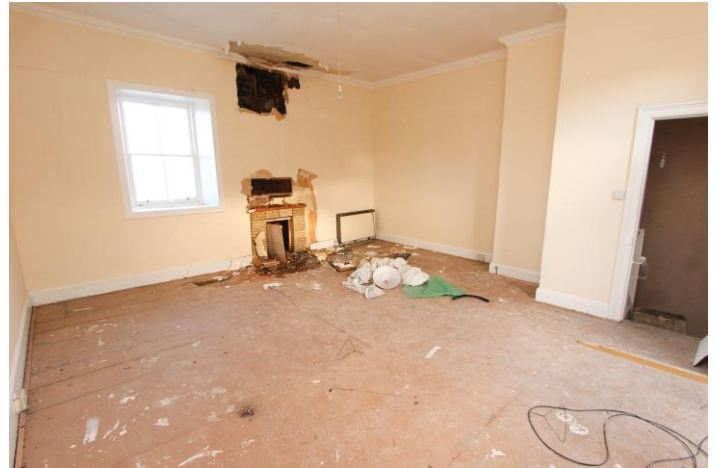
Adjoining cottage lounge
